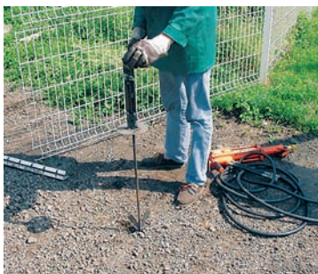
Exemple d'utilisation d'une ancre à percuter lors d'une installation de grillage.
