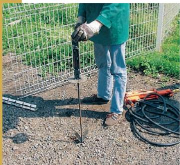
Exemple d'utilisation d'une ancre à percuter
