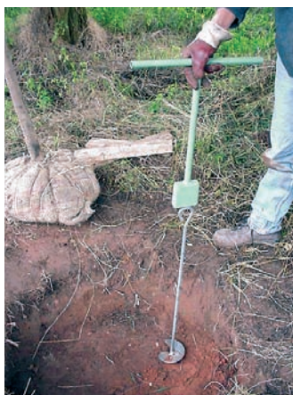
Exemple d'utilisation : ancrage de motte. Mise en place avec une clé manuelle.
